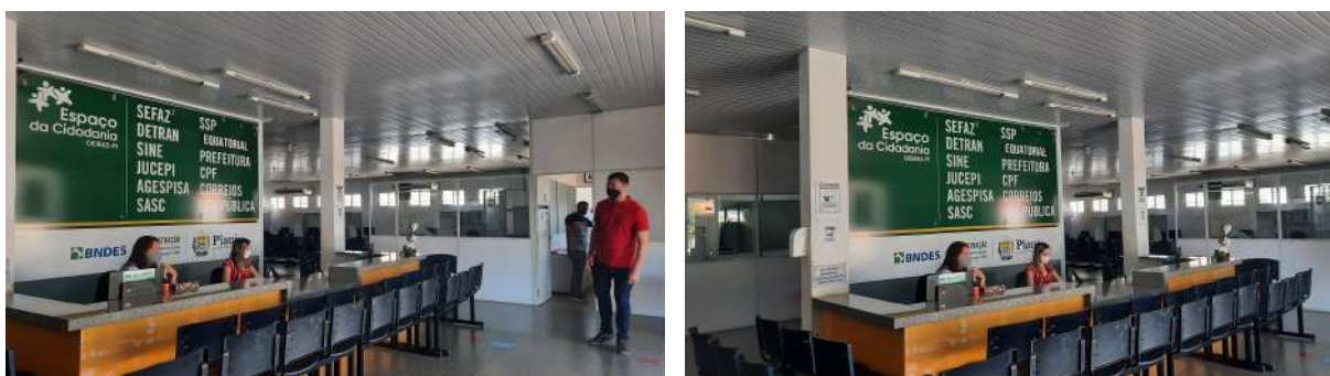
Imagem 12 e 13 – Recepção - Revisão de pontos elétricos/ Substituição de luminárias (JUN/2021)
