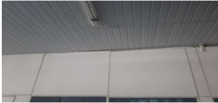
Imagem 20, 21 e 22 – Revisão em estruturas de divisórias navais. (JUN/2021)
